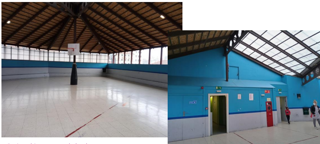
Patio cubierto antes de la obra: suelo deslizante, poca entrada de luz natural, espacio poco atractivo para el juego
