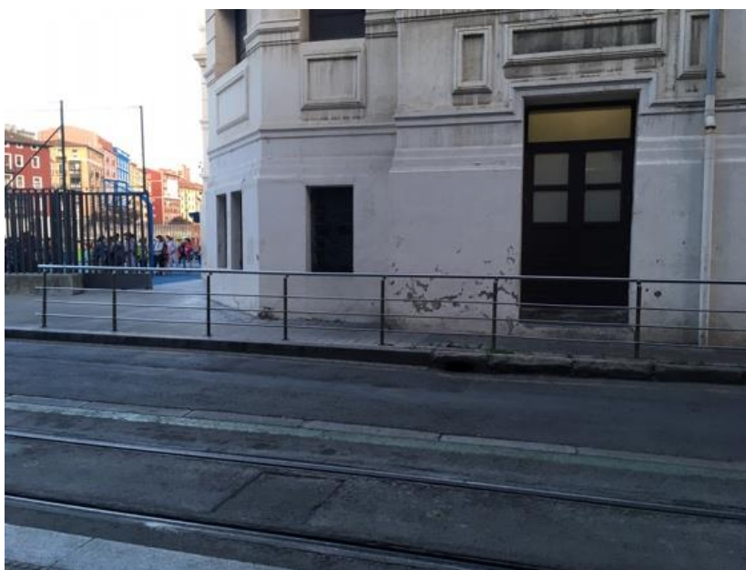
Puertas entrada/salida patio trasero junto a vías del tranvía.
